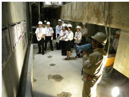
↑大震災に備えて耐震および免震工事が行われていた。建物ごとジャッキアップして免震装置を埋め込むという日本でも例の少ない大規模な工事を見ることができた。
