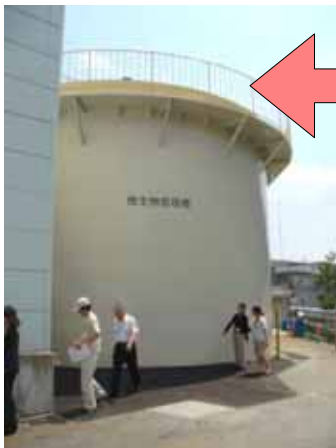
浄水槽の外観 人の大きさと比較して結構な大きさであることがわかる。
