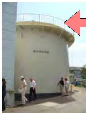
浄水槽の外観 人の大きさと比較して結構な大きさであることがわかる。
