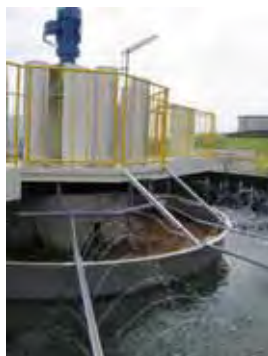
浄水槽内部の様子 左の写真の矢印部分。
