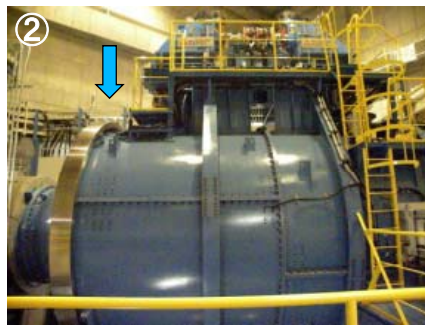
回転ガントリー 治療室の裏側で、照射装置を回転させている。重量約180トン。三菱電機製。
