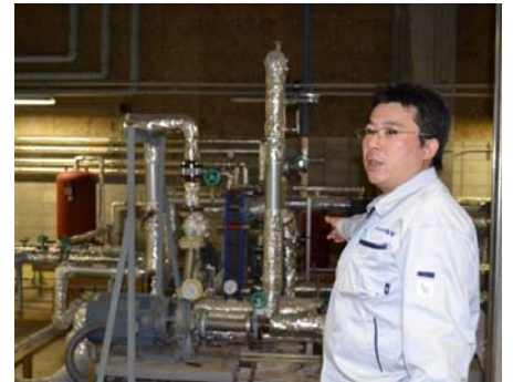
熱交換器と温水を送るポンプ
