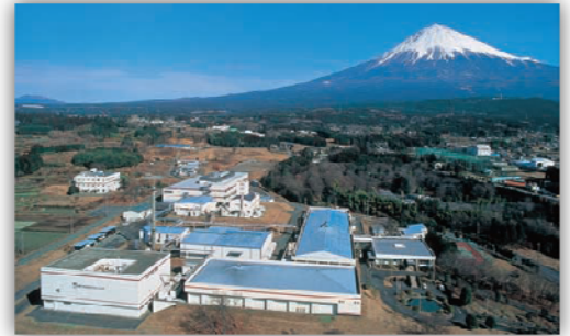
フジヤマ工場
